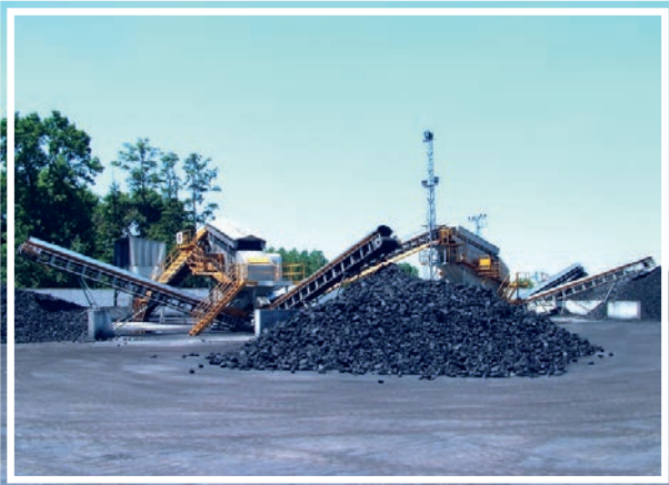
KÖMÜR ELEME ve SINIFLANDIRMA TESİSLERİ
