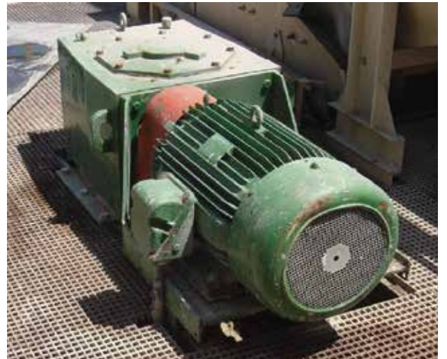
Resim 1. Tank Karıştırıcısı Elektrik Motoru
